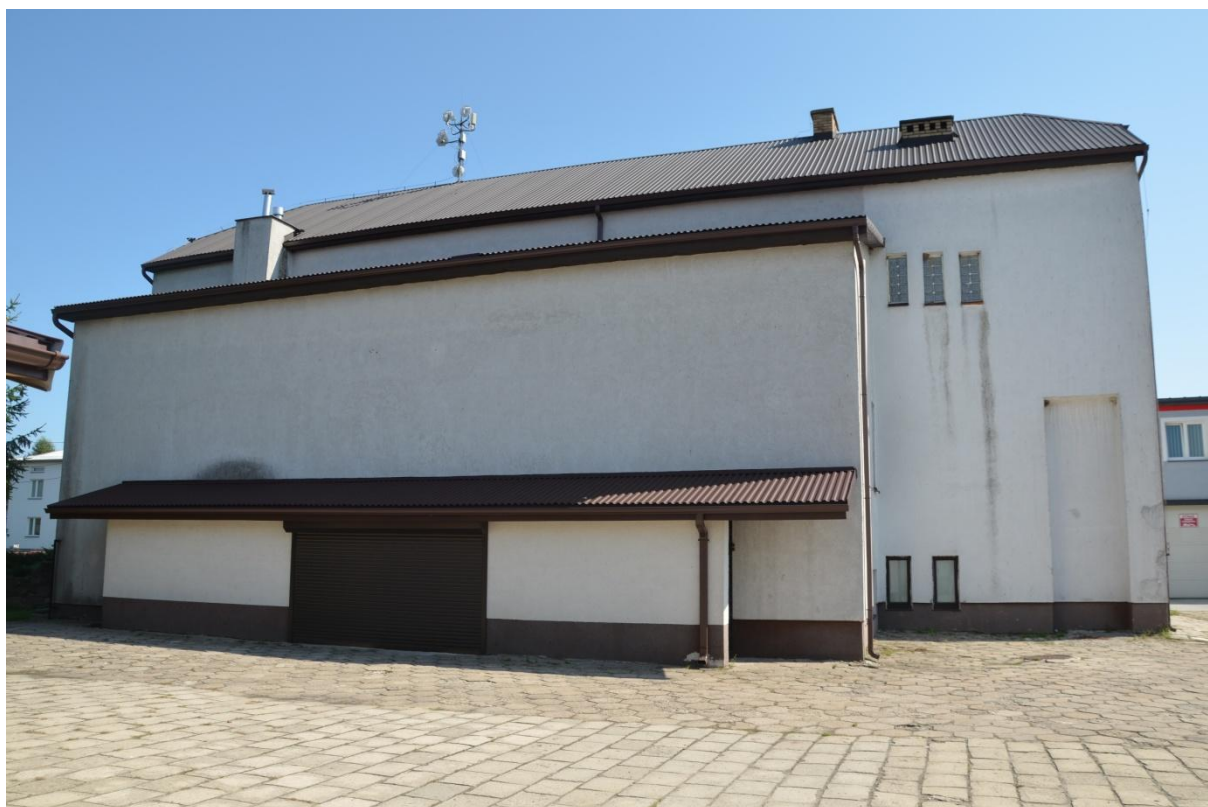
Budynek KDK – widok od strony zachodniej
